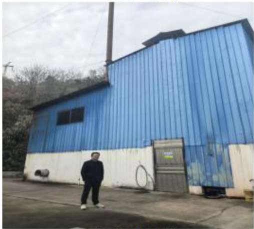
工程师现场照片
