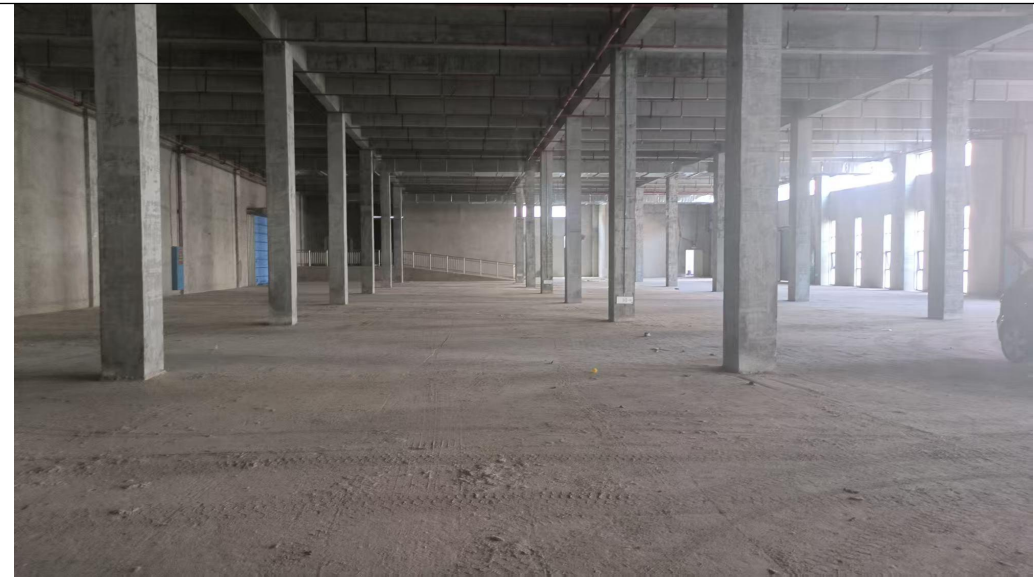
厂房一层内部
