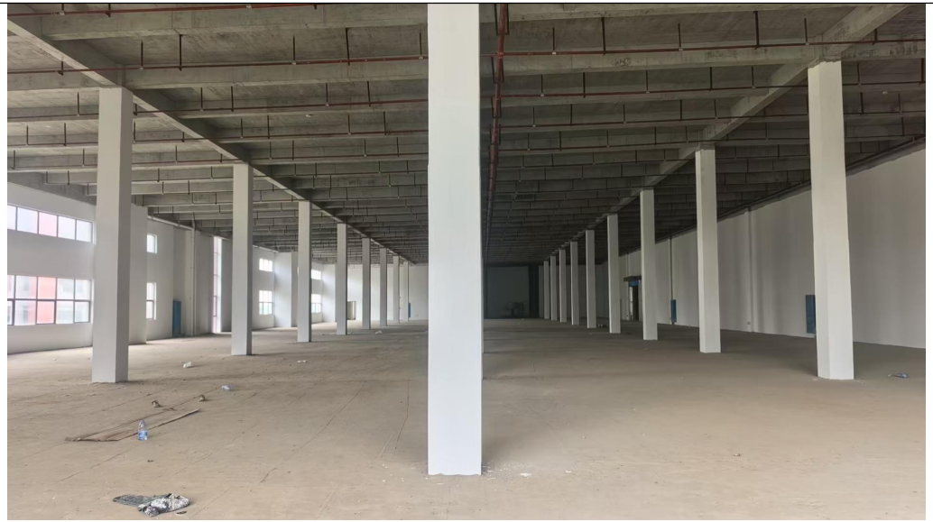
厂房二层内部
