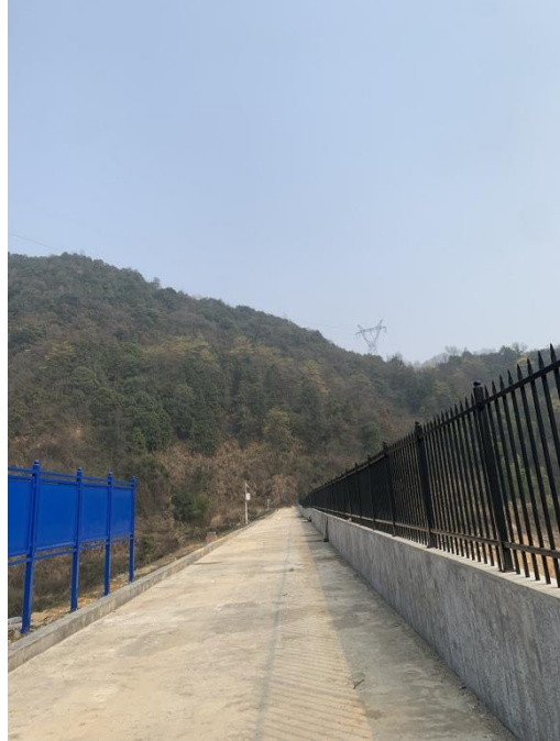
220KV 高压输电线路
