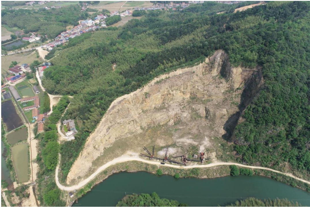
图 3-1 临湘市坦渡胜龙采石场开采现状 重叠区域如下图所示：
