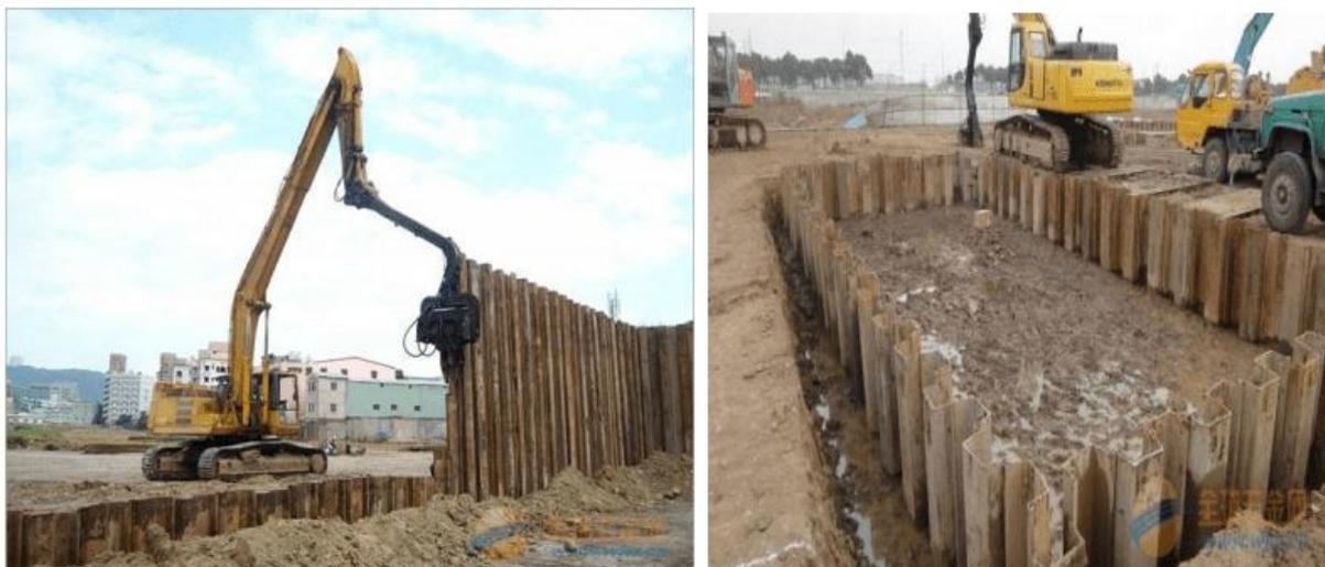
图 4.1-7 垂直阻隔技术—钢板桩墙
