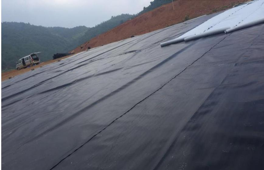
图 4.1-3 水平阻隔技术—HDPE 土工膜衬层
