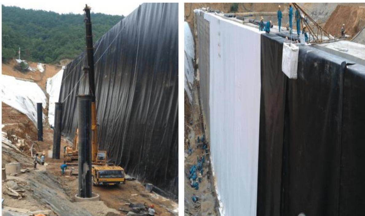
图 4.1-9 垂直阻隔技术—土工膜墙
