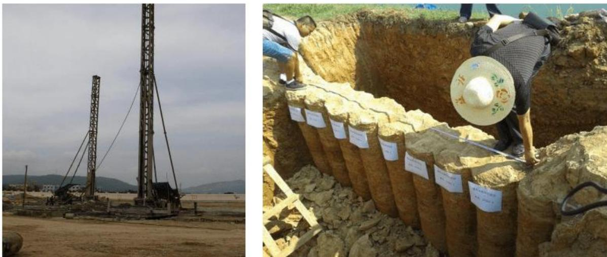
图 4.1-8 垂直阻隔技术—搅拌桩墙
