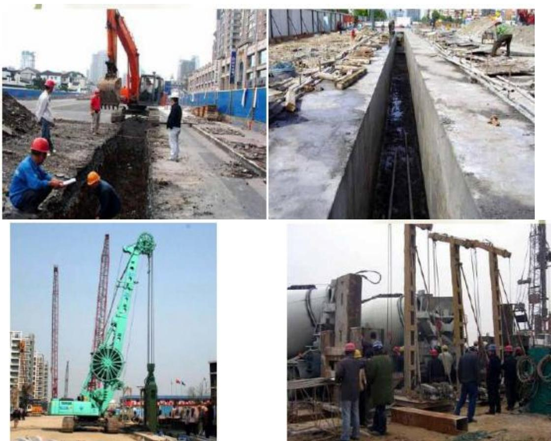
图 4.1-5 垂直阻隔技术—泥浆墙
