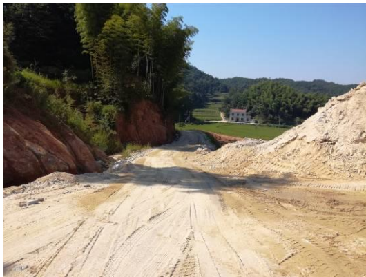
矿区进场道路
